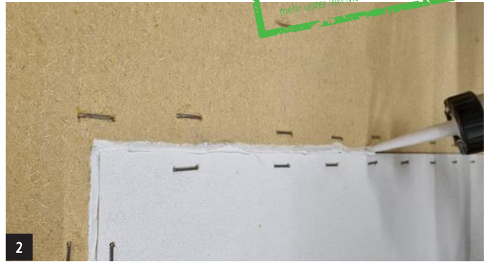
2 Fugen in Fassadenebene mit FDM WALL verschließen
