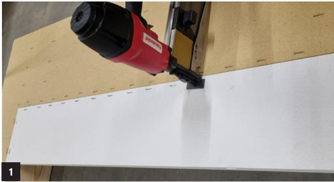
1 STURZBLENDE umlaufend auf halbe Ständer-/ Riegelbreite klammern
